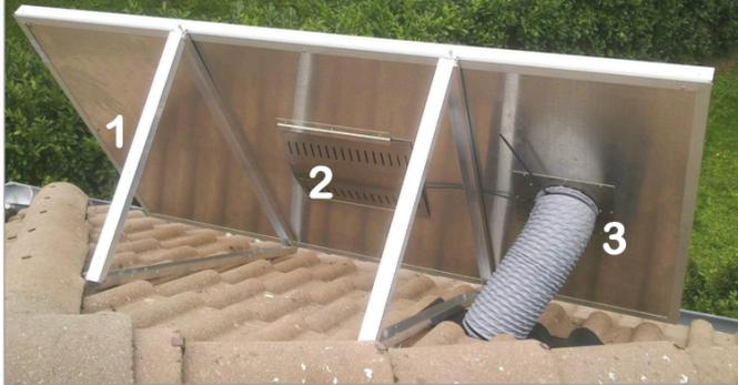
**Pose sur toit :** l'inclinaison de 40 à 60° environ permet d'évacuer l'air chaud par le fond micro-perforé en période de non-utilisation
