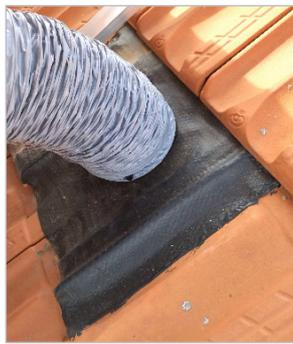
**Toile d'étanchéité :** dans kit toiture, adhésive glissée sous la tuile du dessus posée sur la tuile du dessous
