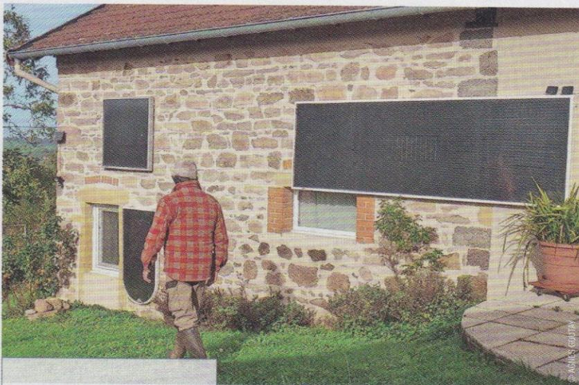
Les capteurs solaires fonctionnent séparément du système de chauffage et peuvent être installés en appoint de n'importe quel système de chauffage : bois, puits canadien, pompe à chaleur.
