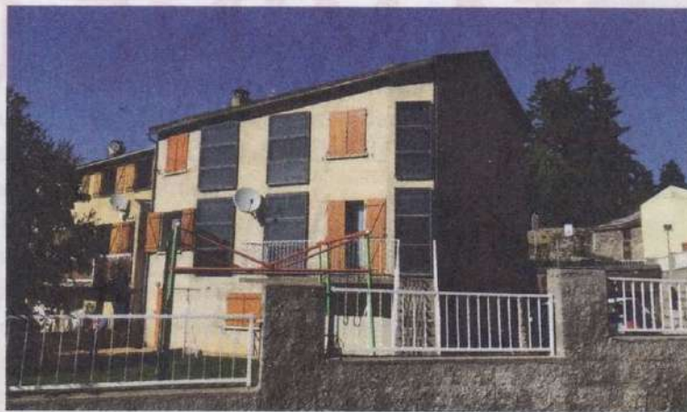
Capteurs solaires sur une façade.
