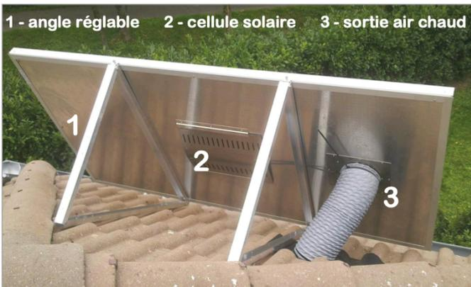
**Pose sur toit :** l'inclinaison de 40 à 60° environ permet d'évacuer l'air chaud par le fond micro-perforé en période de non-utilisation
